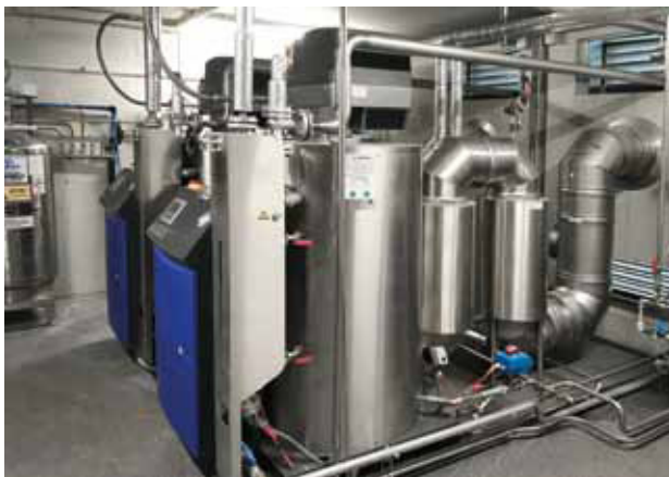
Slika: Postrojenje sastavljeno od više parnih generatora. Drugi sekundarni JUMAG ekonomajzer instaliran je na temeljno postolje uz uštedu na prostoru
