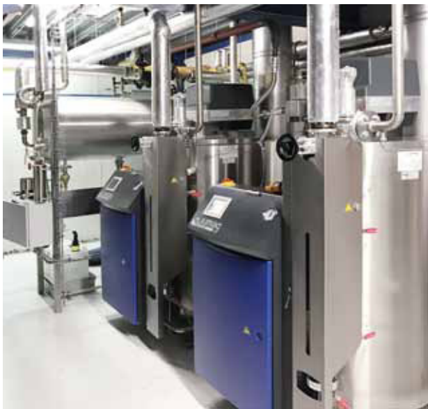
Slika: Postrojenja sastavljena od više parnih generatora, modularne su izvedbe
